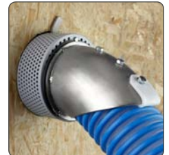
4 Заполните углы конструкции, поворачивая распыляющую головку
