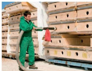
Заполнение деревянных конструкций при помощи выдувного шеста с использованием пылеприемника (пассивный отвод)
